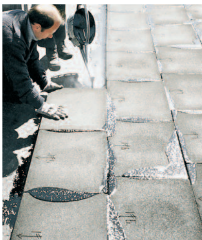
FOAMGLAS® Gefälleplatten; Plattentyp und Gefällrichtung sind eindeutig gekennzeichnet.
