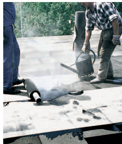
Im Heißbitumen-Gießverfahren wird die Bitumendachbahn unmittelbar auf die FOAMGLAS® Dämmung aufgeklebt.
