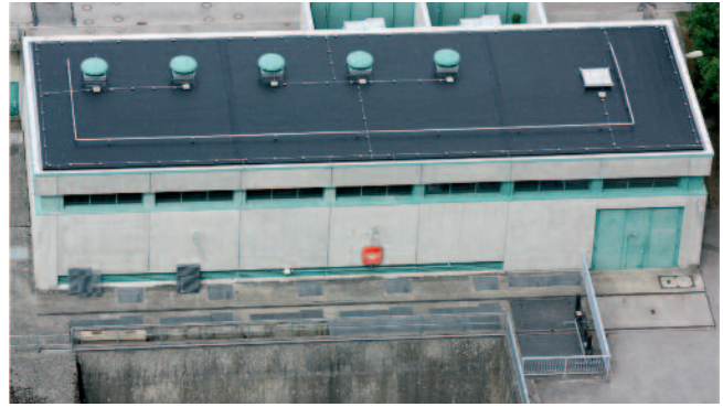
Dach eines Pumpenhauses. FOAMGLAS® Gefälledach mit unterlaufsicherem Kombinations-Abdichtungssystem.
