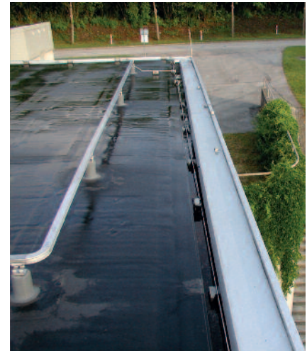
Dachfläche mit Kaltselfstklebebahn.
