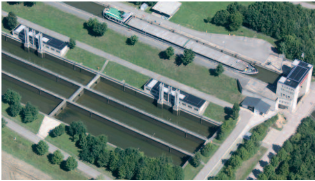
Schleusenanlage in Dietfurt, alle Gebäude mit FOAMGLAS® Kompaktdach und Kombinations-Abdichtungssystem.
