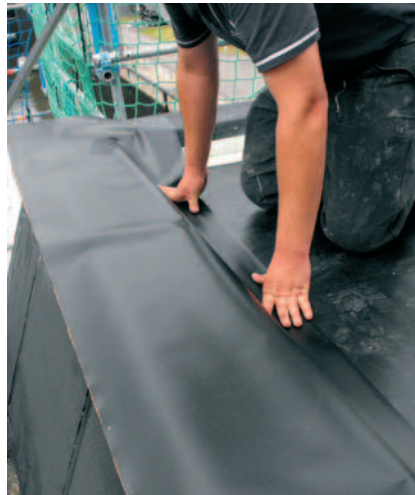
An der Schleuse in Dietfurt wurde die Attika mit einer Wolfin-Bahn abgedichtet.
