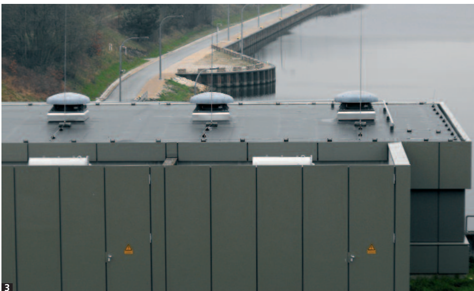
3 Zahlreiche Durchdringungen stellen hohe Anforderungen an den Dachdecker auf dem Pumpenhaus in Bachhausen.
