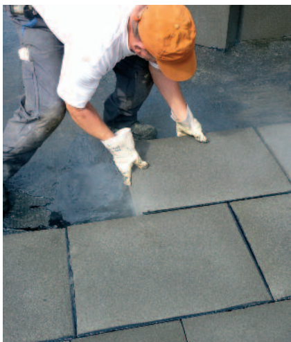
Alle Dachflächen erhielten eine Wärmedämmung aus FOAMGLAS®.
