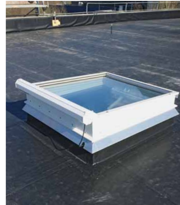
Die speziellen Lichtkuppeln mit vollautomatischer Öffnungs- und Verschattungssteuerung sitzen auf vorgefertigten Aufsatzkränzen.
