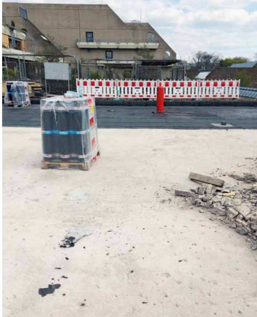
Vor dem Aufbau stand der Abriss: Die gesamte Altdachfläche wurde bis auf die Rohbetondecke zurückgebaut. Eine erste Abdichtungslage dient als Notabdichtung.
