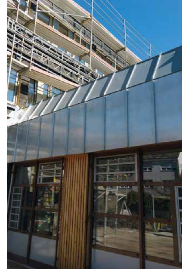
Neben der Neugestaltung der Dachflächen gehörte auch die Erneuerung der Attiken und von Teilen der Fassade zum Aufgabenbereich der Dachdecker.
