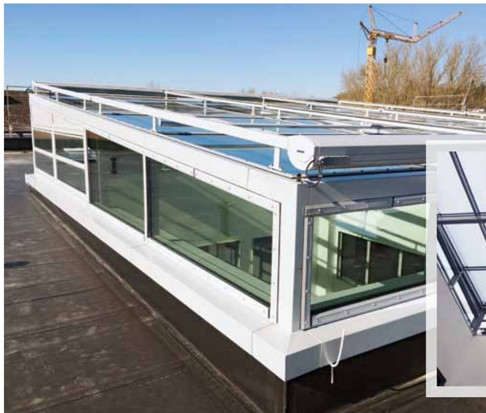
Rund 8 x 8 m beträgt die Größe des neuen Lichtschachts. Die Entlüftung wird über die seitlichen Aufbauten realisiert.
