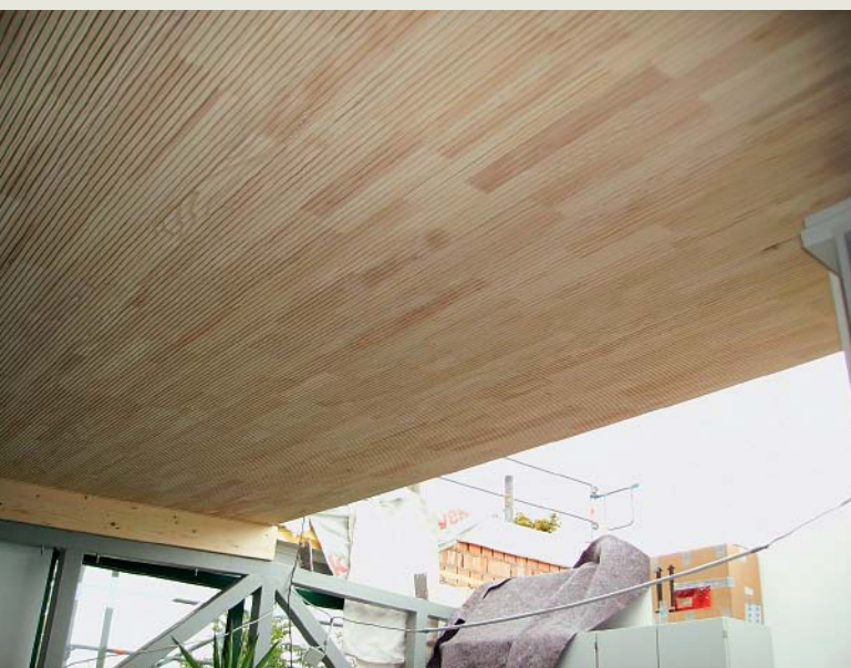
Unteransicht der fertig verlegten Akustik-Holz-kastendecke
