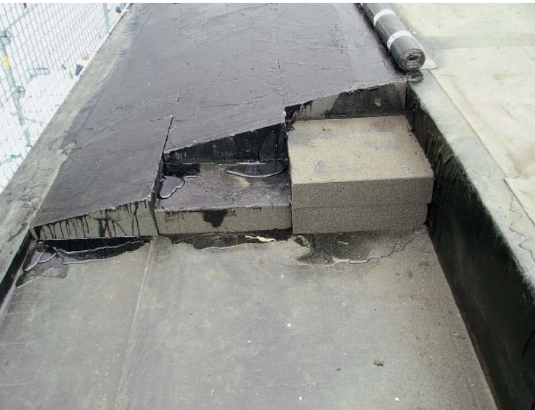
Gebäudesprünge konnten durch Gefälledämmplatten gelöst werden. Vorteil hier: die Gewichtseinsparung.
